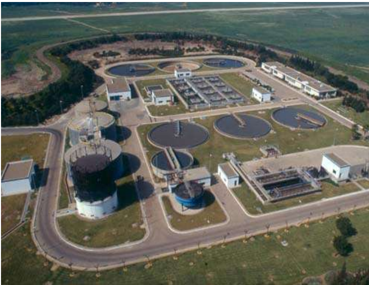
VU AERIENNE DE DE LA STATION D'EPURATION
